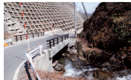
築館栗駒公園線 柳沢橋含む道路拡張
