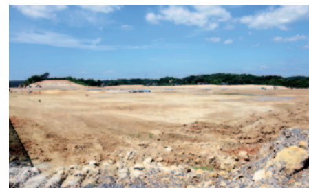
三峰工業団地造成14.3ha(完成間近・市事業)
