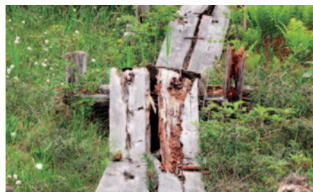
栗駒山 世界谷地第二湿原の木道改修
