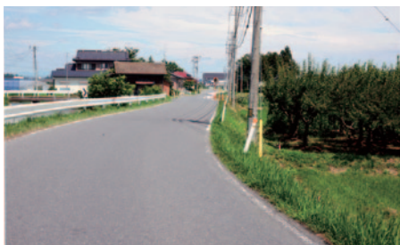
築館若柳線 川原地区（道幅拡張と歩道）
