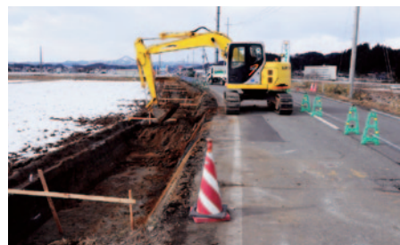
中田栗駒線里谷地区（道路拡張と歩道）
