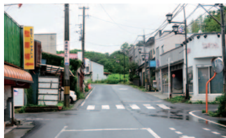
古川佐沼線 瀬峰駅前（道路拡張と歩道）
