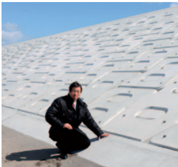
沿岸地区の完成間近の防潮堤を視察
